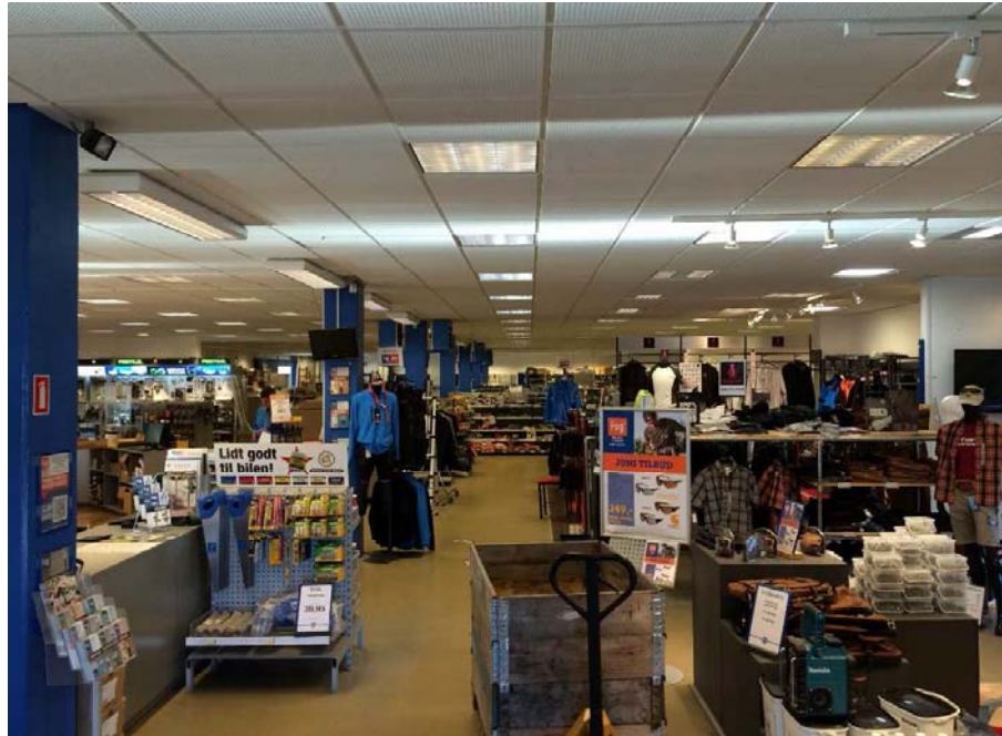
Figur 7-17 Belysningsanlæg med 38W LED-lyskilder.
