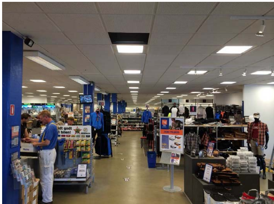
Figur 7-17 Belysningsanlæg med 38W LED-lyskilder.
