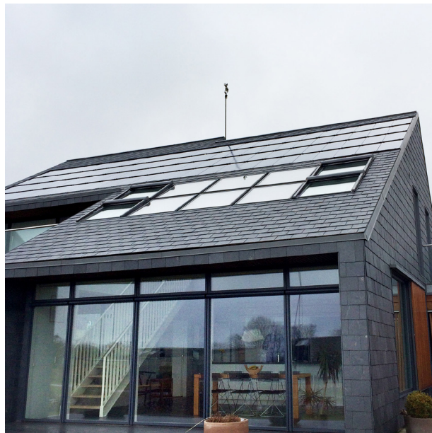
Vippevindue i tag til afkast af luft
